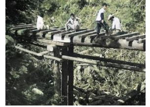
橋を架ける工事の様子
